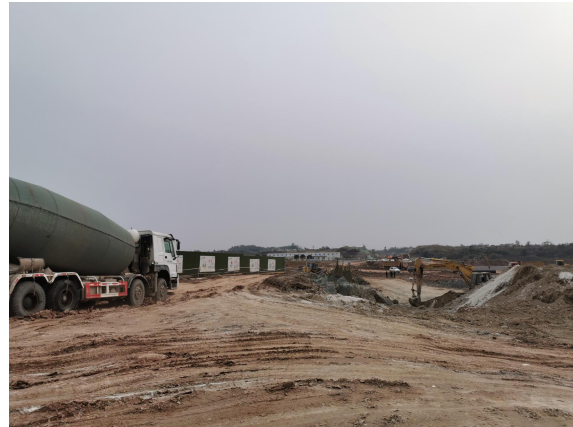
图 3-2 南北大道施工现场
