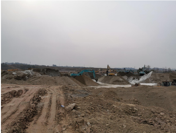
图 3-1 标厂西路施工现场
