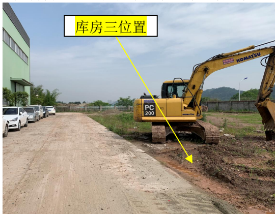
③库房三未建, 现为空地
